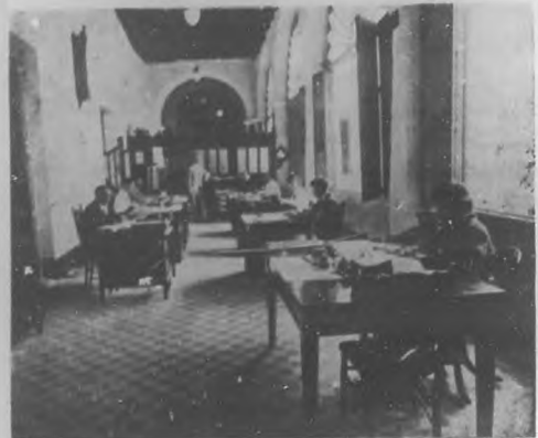
Oficinas del Centro Telefónico de la Habana.
